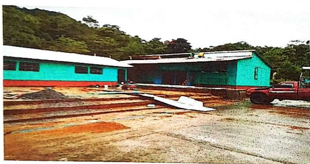
Foto 3: Pintada de paredes interior y exterior
