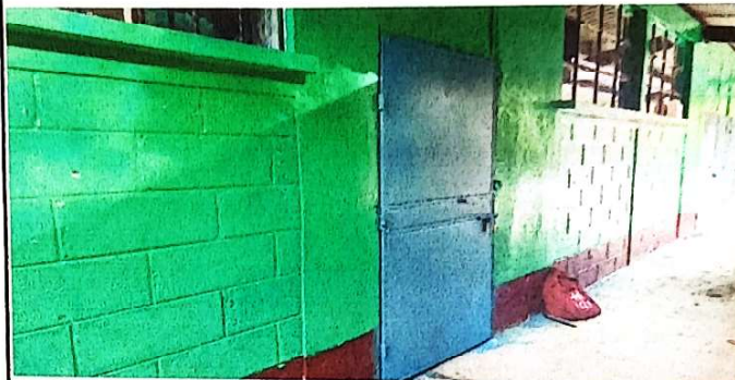
Foto 2: Sustitución de vidrios a lámina luz, pintadas de paredes interior y exterior.
