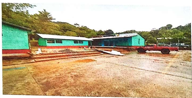
Foto1: cambio de estructura de madera a metal, cambio de Techo, pintadas paredes interior y exteriores, cambio de chaspa y pintada de puerta.
