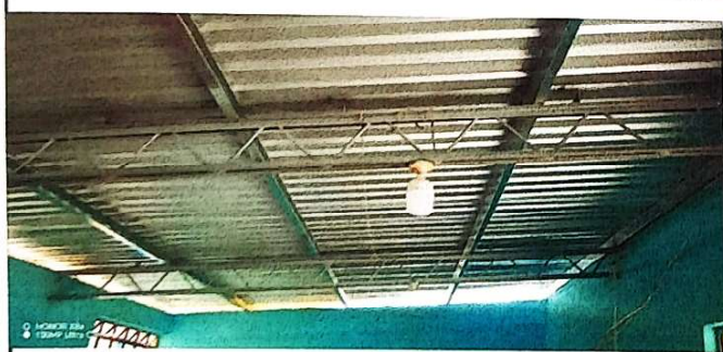
Foto 5: cambio de estructura de madera a metal, cambio de techo.
