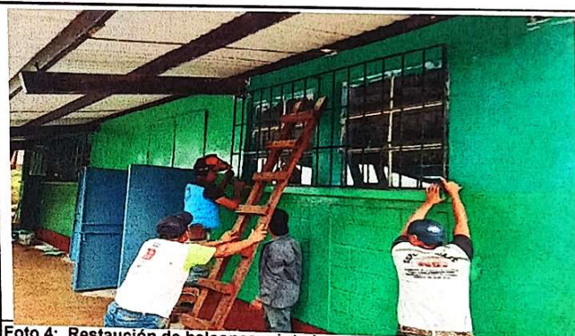
Foto 4: Restaución de balcones, pintadas de paredes y de puertas
